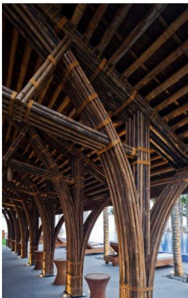
Figura 30: Detalhe do sistema estrutural com tesouras em feixes de bambus de médios diâmetros Fonte: <http://votrongnhia.com/projects/naman-beach-bar/>
