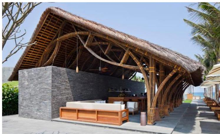
Figura 29: Sistema estrutural com tesouras em feixes de bambus de médios diâmetros
