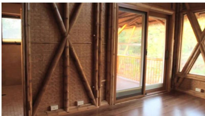
Figura 15: Detalhe dos painéis pré-fabricados da BambooLiving
