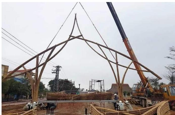
Figura 31: Detalhe da tesoura sendo posicionada.
